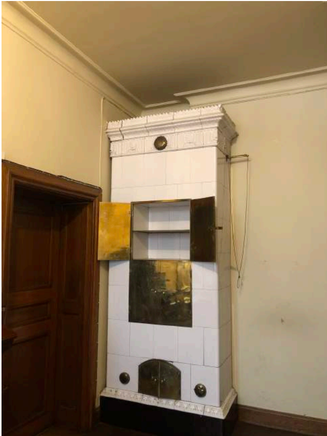
Kakelugnen i Övre serveringsrummet med hyllor för att kunna värma upp tallrikarna innan serveringen.
