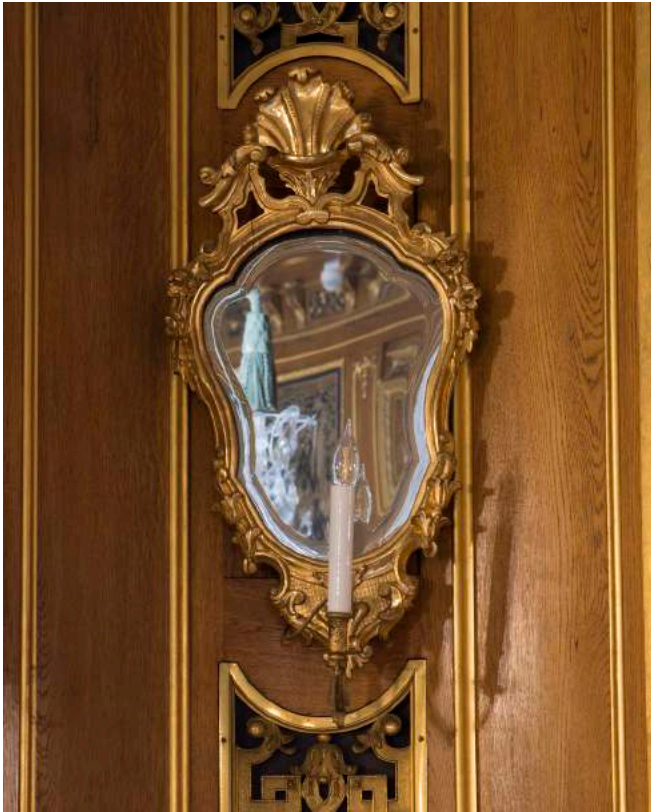
Ovan och under lampetten i hörnet syns ventilations-systemets galler.
